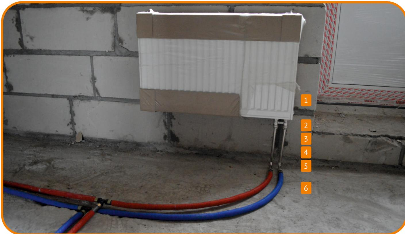
1. Предварительно установленный радиатор с нижним подключением. 2. Узел для нижнего подключения радиатора Н-образный, евроконус G3/4-R3/4 евроконус, прямой (арт. 39101). 3. Адаптер компрессионный 15-G3/4 евроконус (арт. 37102). 4. Трубки L и Т-образные Ø15 для подключения радиатора (арт. 34016-34125). 5. Монтажная гильза (арт. 30116-30125). 6. Труба Sanline PEXa/EVOH «Универсальная» в защитной трубе ПНД гофрированной.
